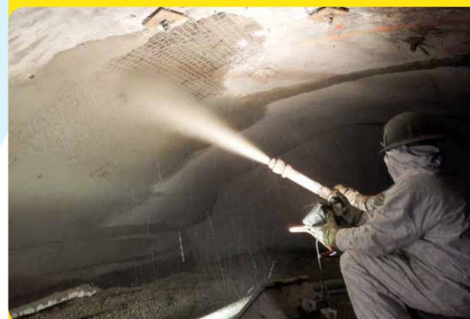
Une fois les fissures réparées en profondeur, on pose un treillis sur lequel est projetée une préparation de béton. Cette méthode nous évite d'avoir à fabriquer des coffrages.
